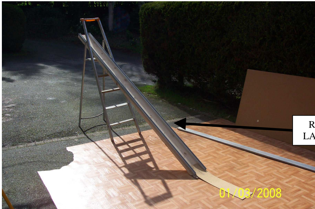
Tracé au sol pour positionner la rampe
