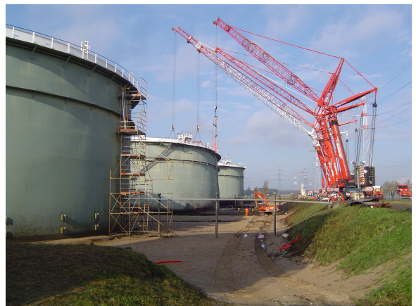
Figure 4: Grandes grues utilisées pour stabiliser le réservoir D2 Photo DR
